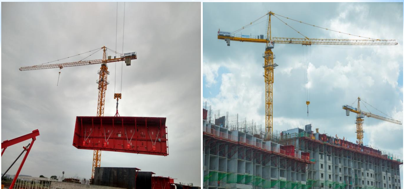
1-расм, кран ёрдамида универсал қолипнинг кўтарилиши ва ўрнатилиши.
