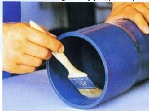
6-расм Елимни қувурга суриш вақтида мўйқаламни доимо ўқ бўйича ҳаракатлантирилади
